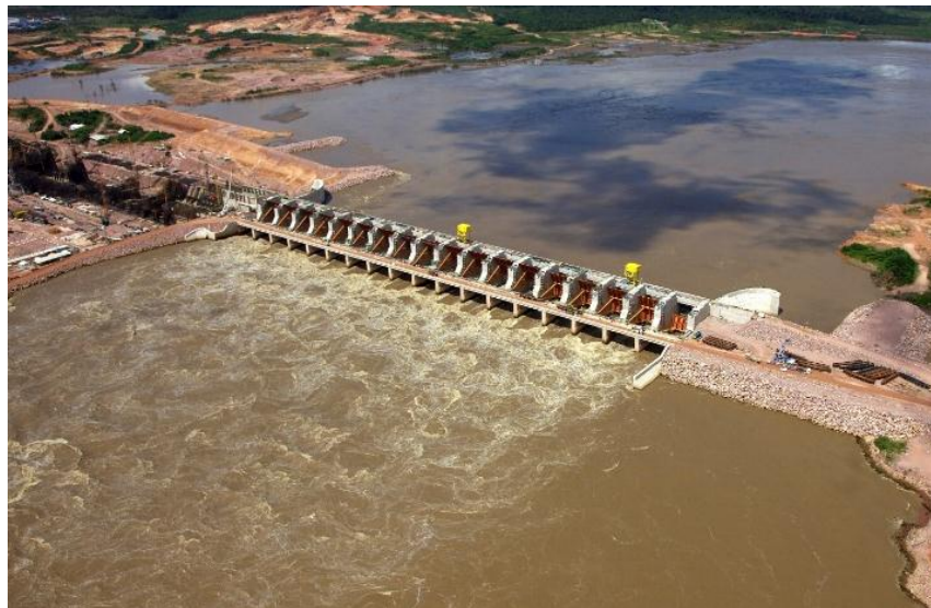
Figura 2. Construção da UHE JIRAU/RO
