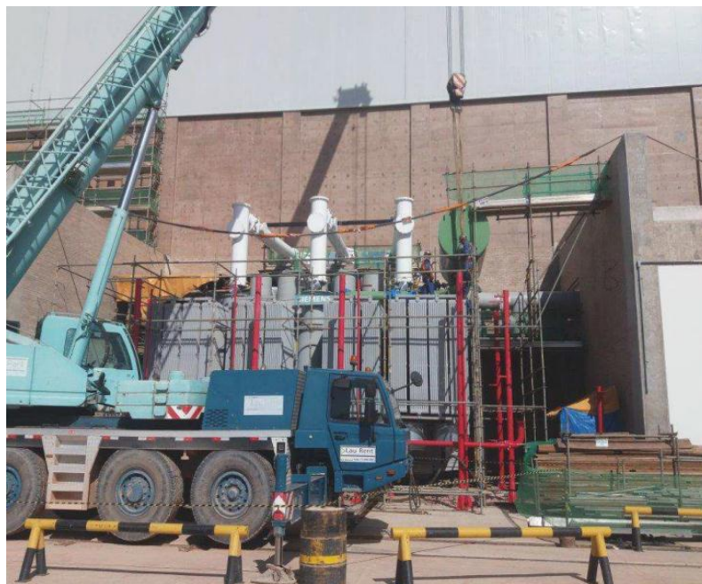
Figura 9. Instalação de componentes pesados
