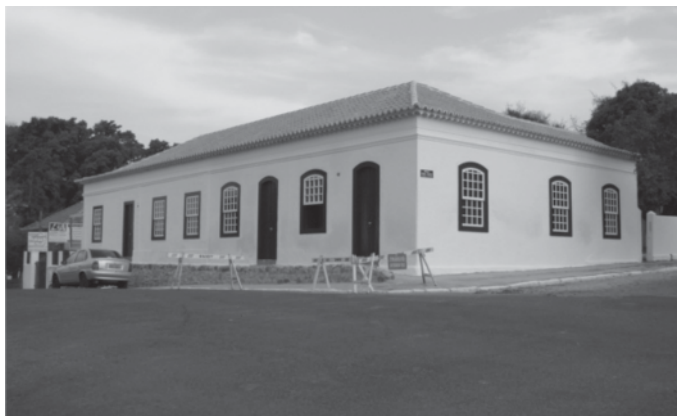
Figura 3 - Fachada da Casa Gomes Jardim após o restauro arquitetônico.
